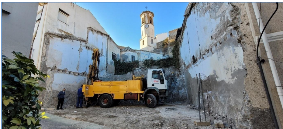
Emplazamiento penetrómetro P-2.
