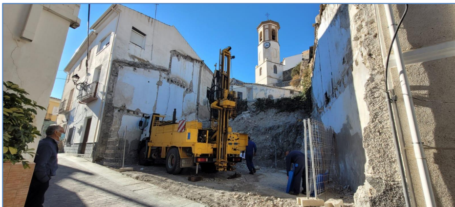
Emplazamiento de sondeo S-1.
