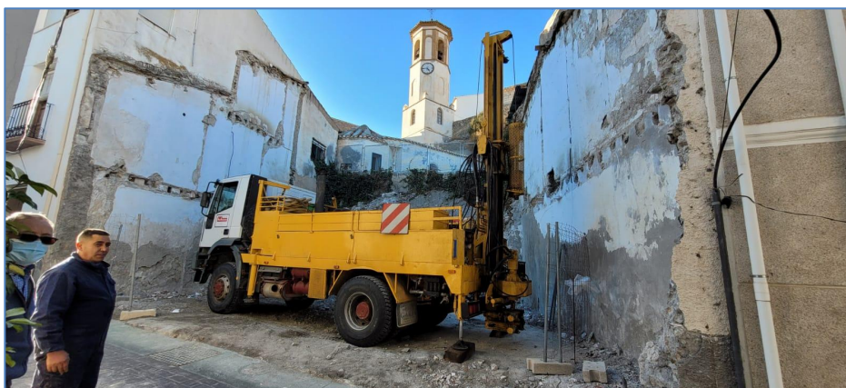
Emplazamiento penetrómetro P-1.
